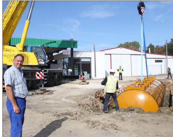
■ « La station ouvrira avant la fin de l'année », annonce Michel Didier, garagiste, lors de l'installation de la nouvelle cuve. Photo Xavier DUMESNIL
